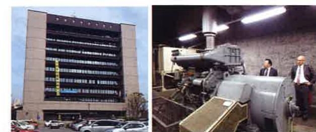
当面の活用が決まった静岡市清水庁舎。4Fに設置されている非常用発電機(=右写真)地階の電気室には防潮扉も設置されている。
