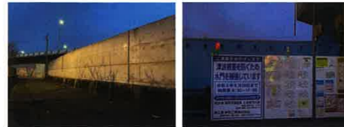
静岡県の海岸堤防の補強工事と本工事により、100年に一度のレベルの津波に対して周辺の津波浸水想定区域がゼロになりました。
